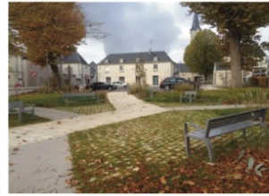
Des matériaux perméables pour la place de la mairie rénovée
