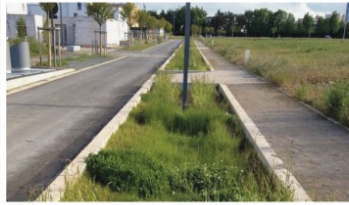
Une avenue désimperméabilisée qui infiltre l'eau de ruissellement de la départementale
