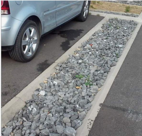
Une tranchée drainante + Cailloux en surface
