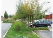
Une noue d'infiltration sur le parking de la supérette
