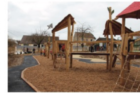
Une aire de jeux avec des revêtements amortissants perméables
