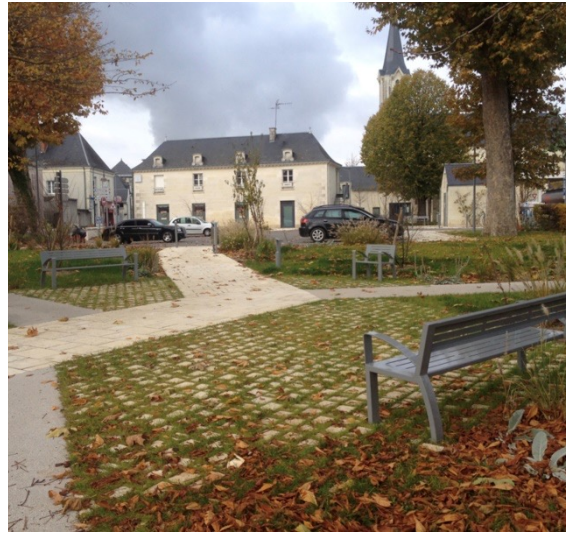
Des matériaux posés sur sable pour les espaces piétons
