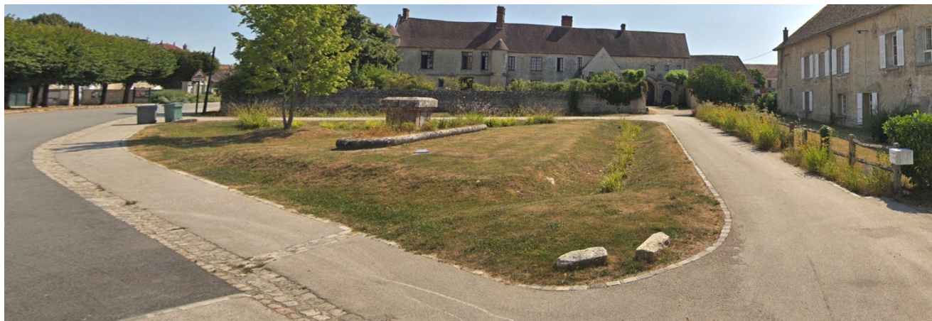
Omerville, un cœur de village « en creux » pour lutter contre les inondations (extrait du webinaire des mardis de l'eau)
