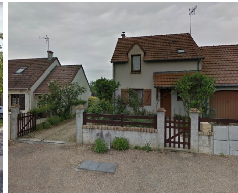
Des espaces de stationnement simples et infiltrants, Rhodon (41)
