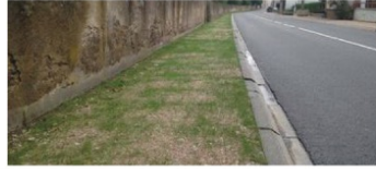
Des trottoirs en grave enherbée dans le lotissement
